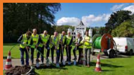
Aanleg van glasvezel
