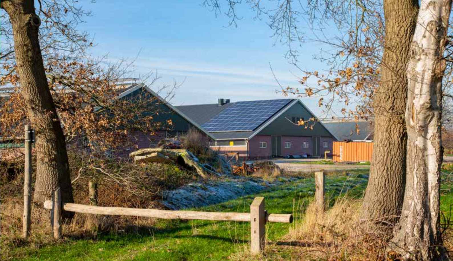
Op staldaken in De Glind liggen al de nodige zonnepanelen.
